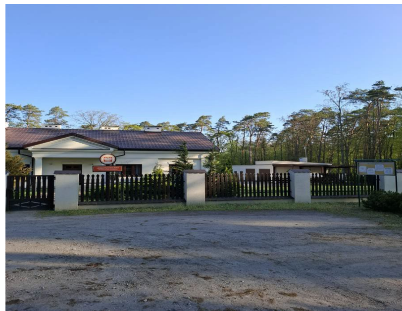
Fot. Budynek Leśniczówki Rydzyny wraz z infrastrukturą towarzyszącą
